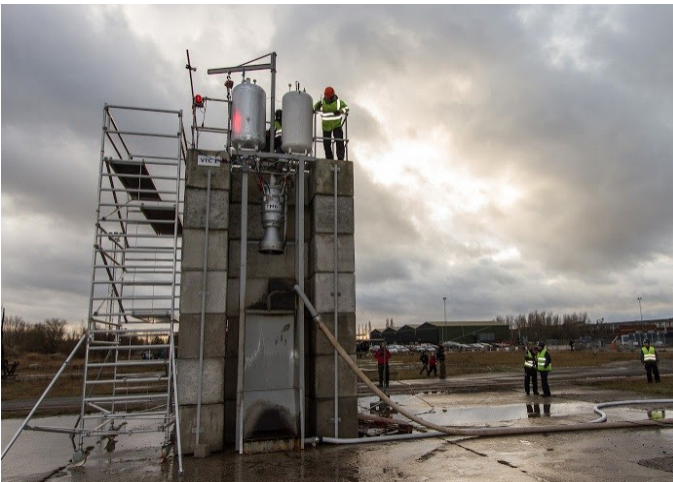
Construção da base de testes de lançamento de foguetes do projeto Copenhagen Suborbitals. Foto extraída do seu site de fotos: https://picasaweb.google.com/114657365514543526210/30122012TM653rdTest?noredirect=1#5827831844053550226
